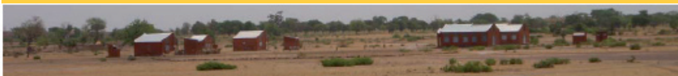
Vue du CSPS : Logement de la femme accoucheuse, dépôt pharmaceutique, logement de l'infirmier, maternité et dispensaire
